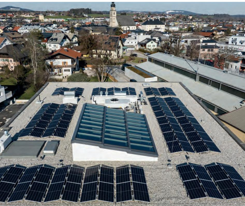
Das Bezirksgericht Seekirchen ist an die Biomasse-Nahwärme angeschlossen und produziert einen Teil des Stroms mit einer Photovoltaik-Anlage auf dem Dach selbst.
